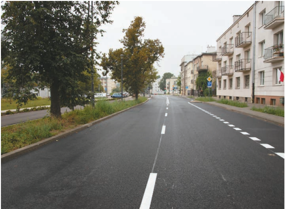
W 2023 r. Zarząd Dróg Miejskich przebudował ciąg ulic Rudnickiego, Perzyńskiego i Podczaszyńskiego (na zdjęciu). Fot. ZDM Warszawa/Anna Mazurowska.
