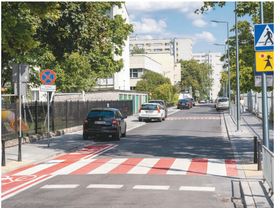
Na ul. Staffa wyremontowaliśmy chodniki, położyliśmy nową nawierzchnię jezdni i zmodernizowaliśmy oświetlenie. Fot. W. Artynew.
