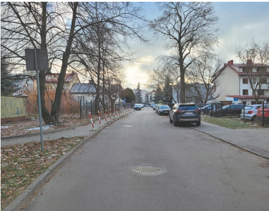
W 2024 r. zostanie przygotowana dokumentacja techniczna, niezbędna do zmodernizowania ulic Renesansowej (na zdjęciu) i Dzierżoniowskiej. Fot. arch. red.
